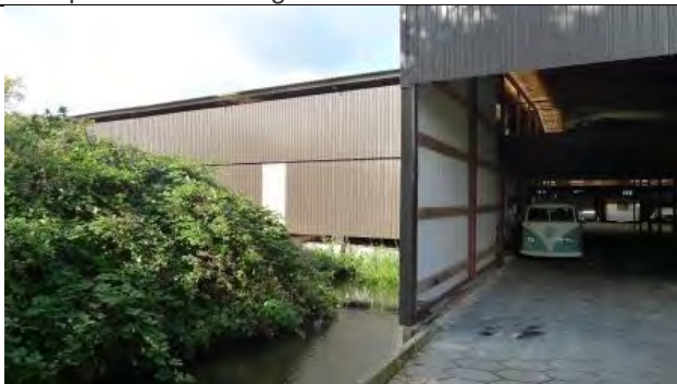
Doorgang naar werkplaats 3 en 4. Bij opslag 1 zijn de ventilatieopeningen zichtbaar
