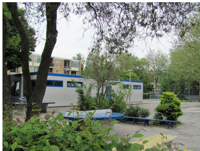
Figuur 3: Bijgebouw basisschool De Tweeklank
