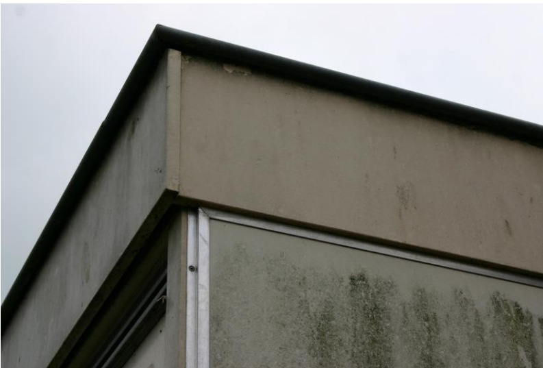
Figuur 4.2.3. Het houtwerk van de dakkapellen sluit overal nauw aan.
