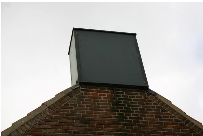
Figuur 4.2.5. Rond elke schoorsteen is een bekisting aangebracht.
