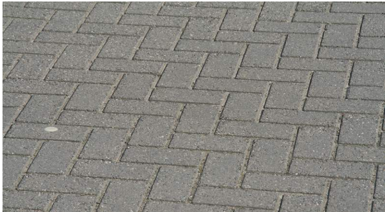
Parkeerhoven, betonstraatsteen lichtgrijs
