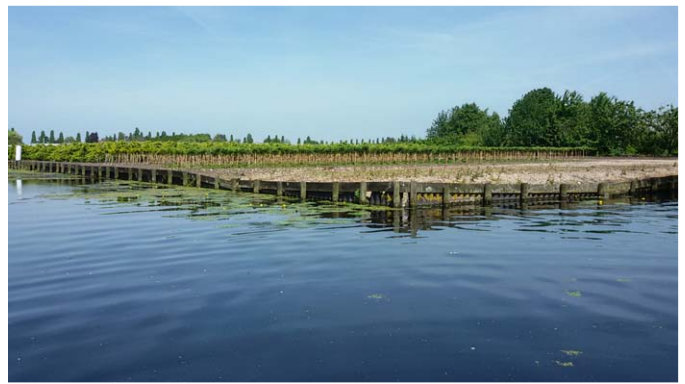
foto 12 - asbestverdacht object MV03
