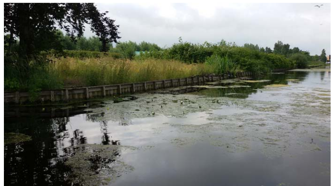
foto 14 - asbestverdacht object MV03
