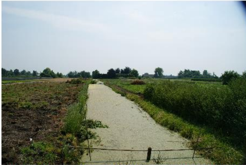
Figuur 1: overzicht projectgebied aan weerszijden van de te dempen sloot en rechts de opslag met voornamelijk sneeuwbes. Rechts achterin zijn de werkzaamheden voor de bouwweg in gang.
