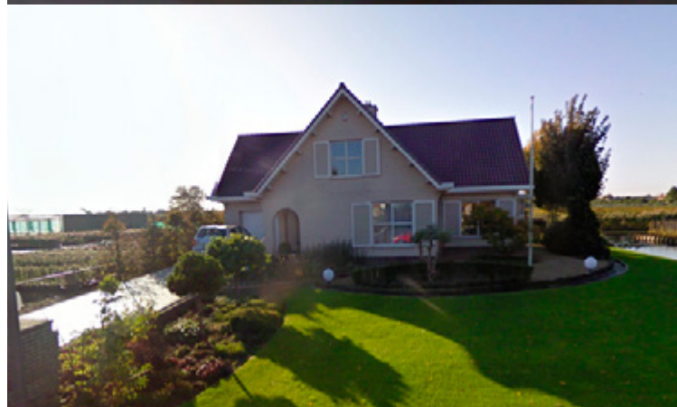
afbeelding 7 | Bedrijfsgebouw en bedrijfswoning zijn beide potentieel geschikt voor verblijfplaatsen van vleermuizen
