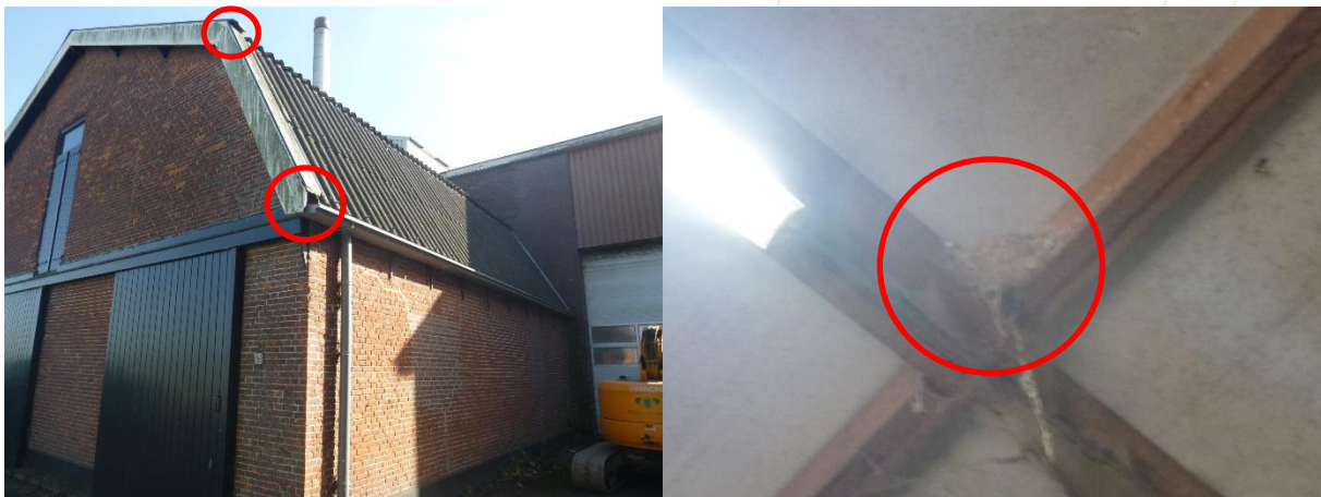
Figuur 3-1. Links de oude stal van deelgebied 1; openingen in de daklijst zijn rood omcirkeld en verder bezit het gebouw dakpannen. Rechts een zwaluwnest in een van de oude schuren.
