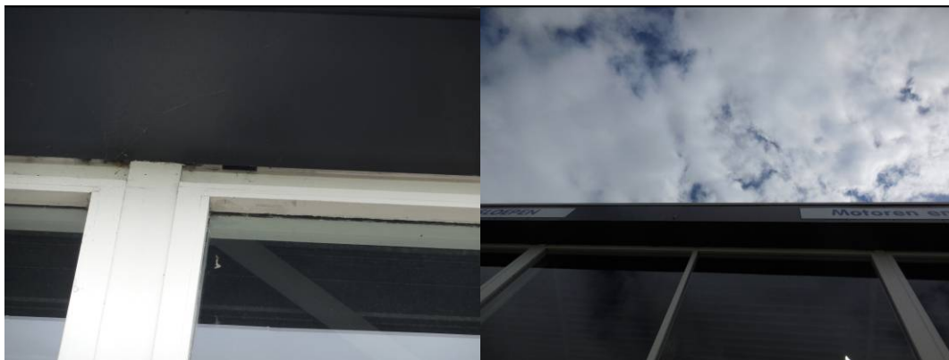
Figuur 2.1 Betimmering met spleten (links) en dakrand (rechts) van de loods.
