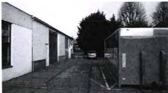
Bestaande verbinding met jaagpad naast Hoogvliet
