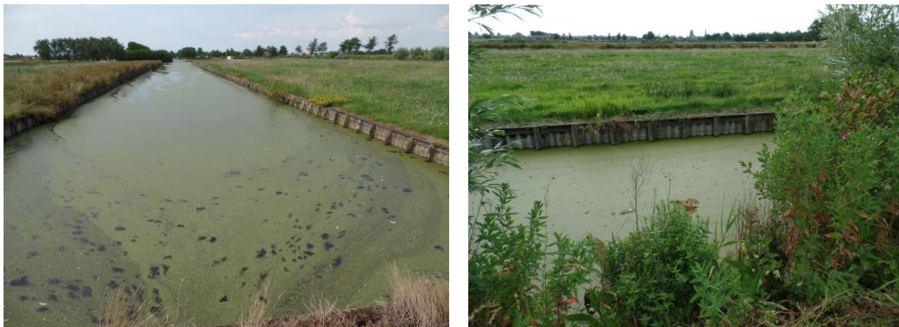
Figuur 17: de middensloot op perceel B en C (links) en de sloot aan de oostkant van het plangebied (rechts).
