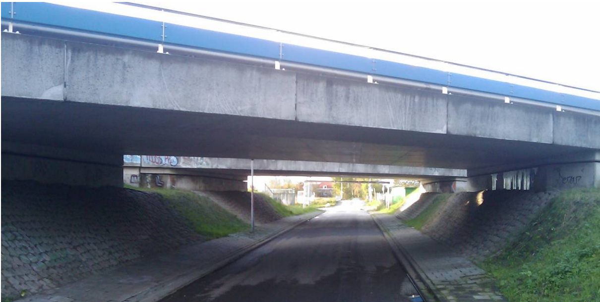
Afbeelding 5: de bestaande onderdoorgang
