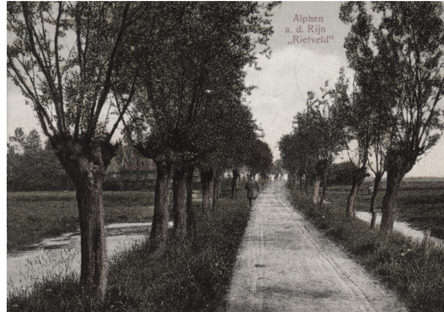
Rietveldsepad in het verleden
