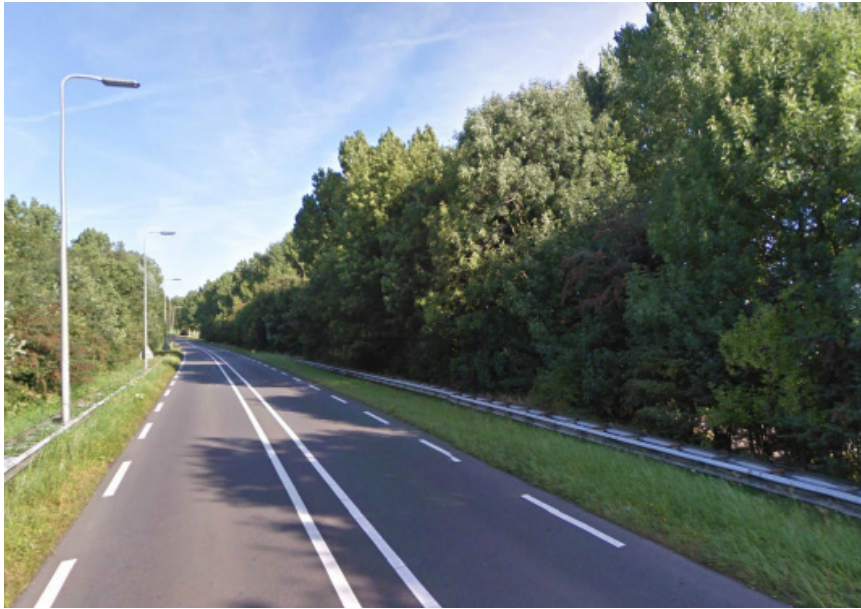
Zegerbaan beplanting blokkeert het zicht in het oostelijke deel
