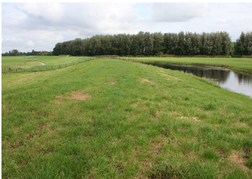
De ringdijk van de polder Vierambacht markeert het bovenland van Oudshoorn
