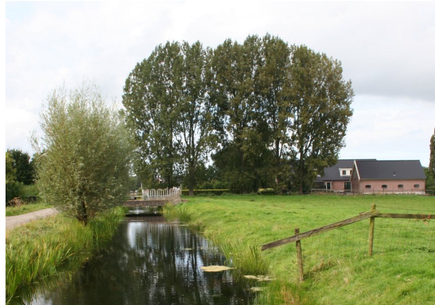
Betonnen brug over de sloot aan de Ridderbuurt
