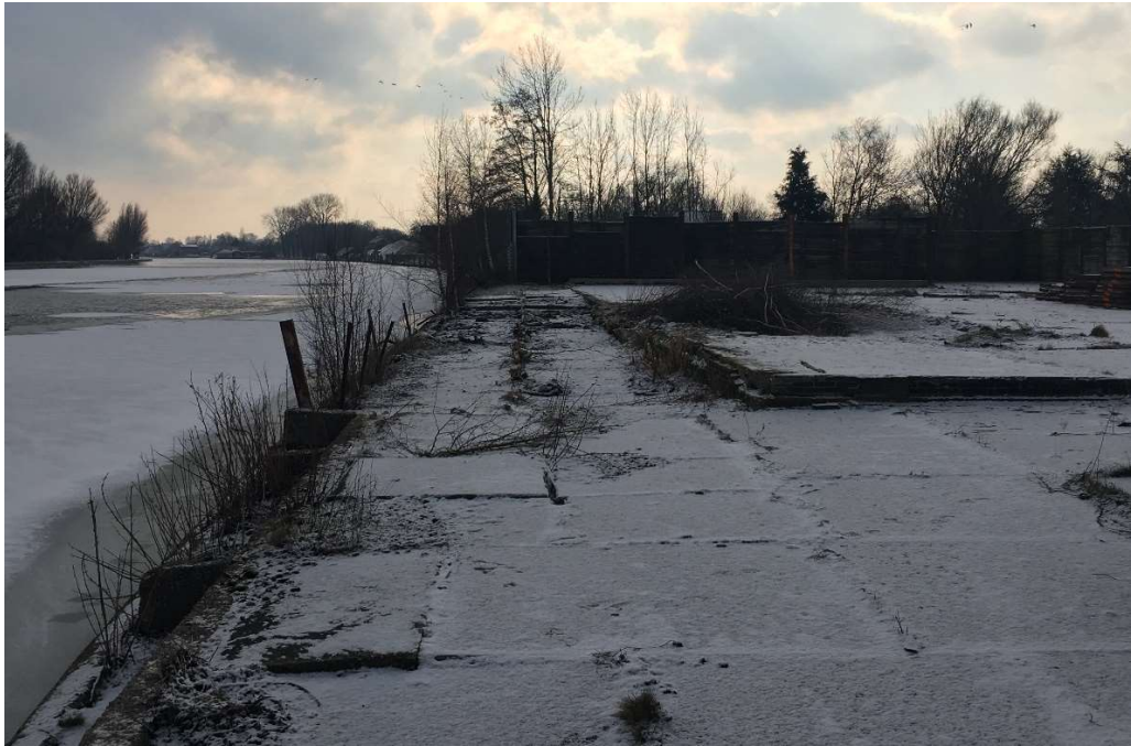
Figuur 3 De bestaande bebouwing is reeds gesaneerd, de fundering van de verwijderde bebouwing is nog aanwezig.
