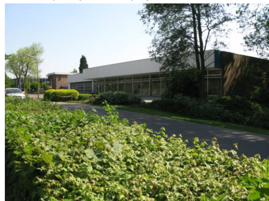
Voor het garagebedrijf zijn voldoende stallingsmogelijkheden voor (vracht-)auto's.
