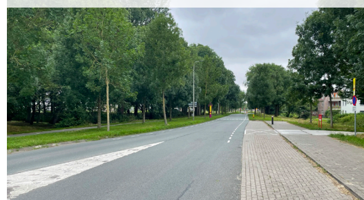
Steekterweg gezien vanaf rotonde
