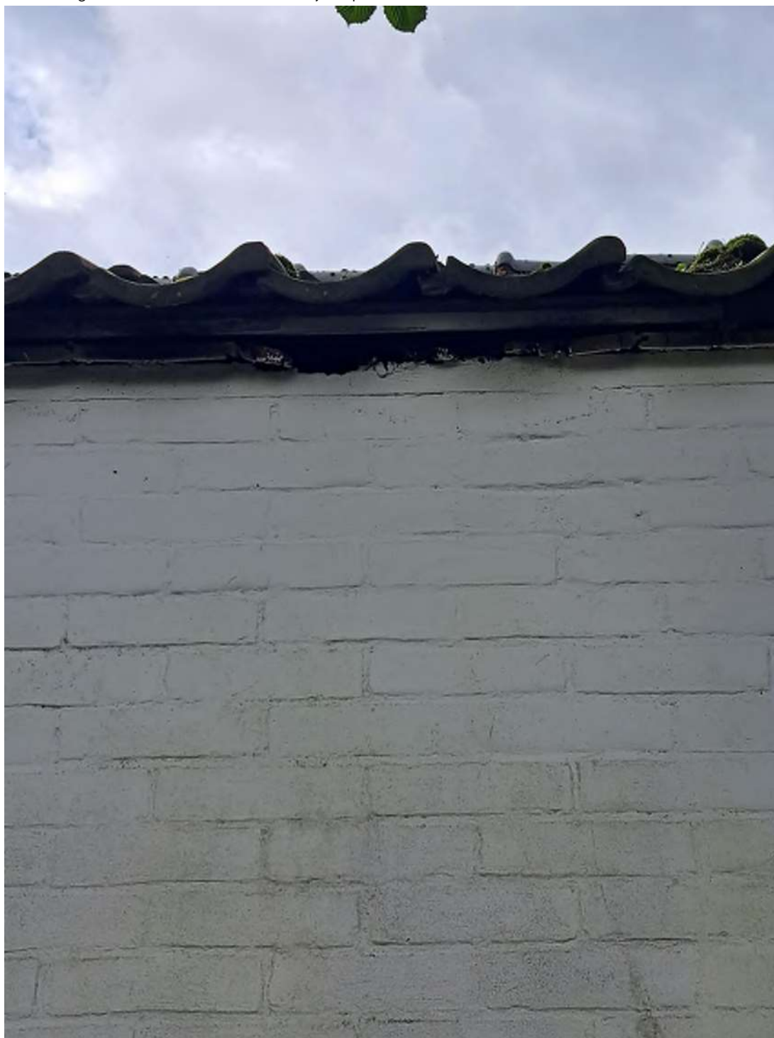
Afbeelding 8: ruimte onder de onderste rij dakpannen
