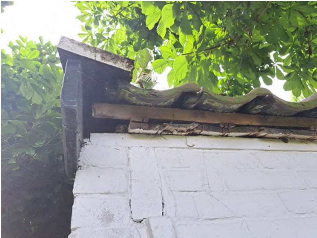
Afbeelding 10: ruimte achter windveer aan de kopgevel
