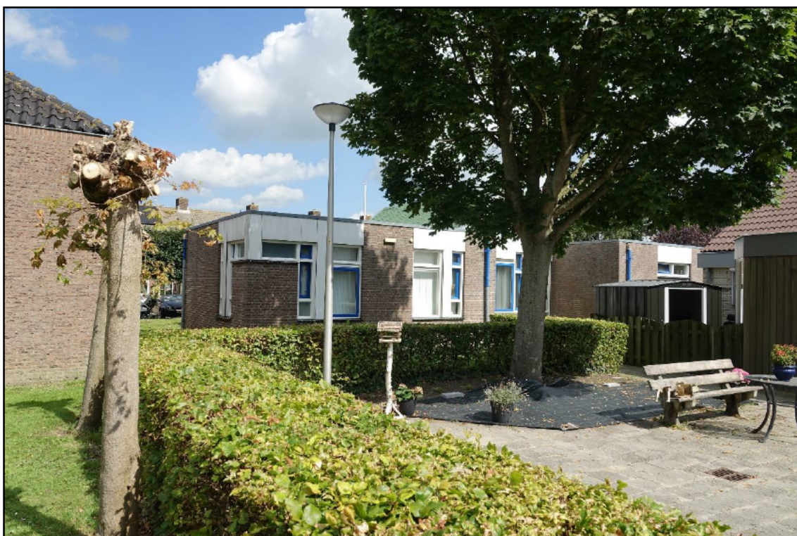
Figuur 3: De achterzijde van het plangebied, gezien vanuit het zuidwesten richting het noordoosten. Zichtbaar zijn het hofje met de lage heg en esdoorn.
