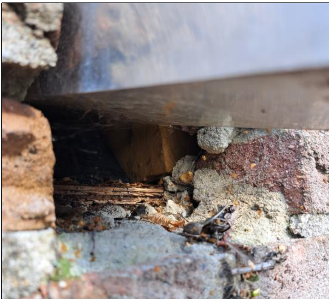
Figuur 7: Detailfoto van de ruimte rondom de hemelwaterafvoer buis. De ruimte leidt niet naar een spouwmuur.
