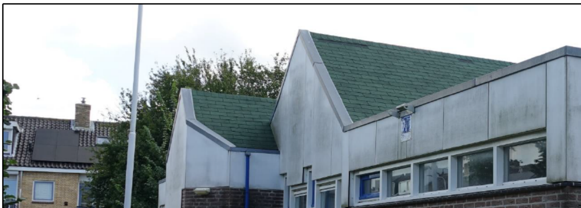
Figuur 8: Het centrale deel van het dak is bedekt met groene bitumen dakplaatjes, lokaal gerepareerd met zwart bitumen, welke goed sluiten en geen openingen bieden.
