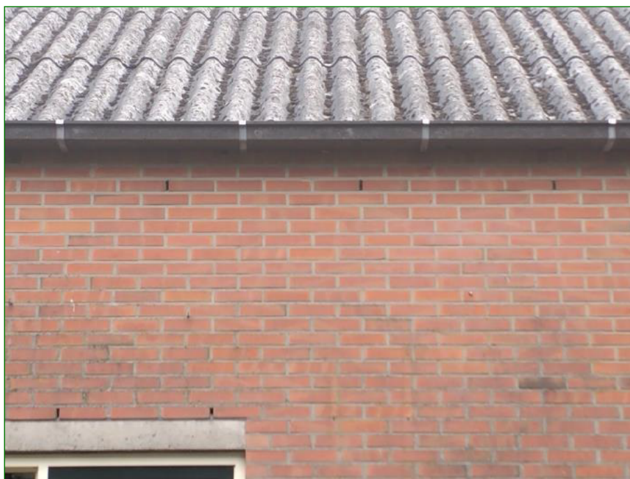
Open stootvoegen aan alle zijden van de bedrijfsloods geven toegang tot voor gebouwbewonende vleermuizen geschikte holtes.
