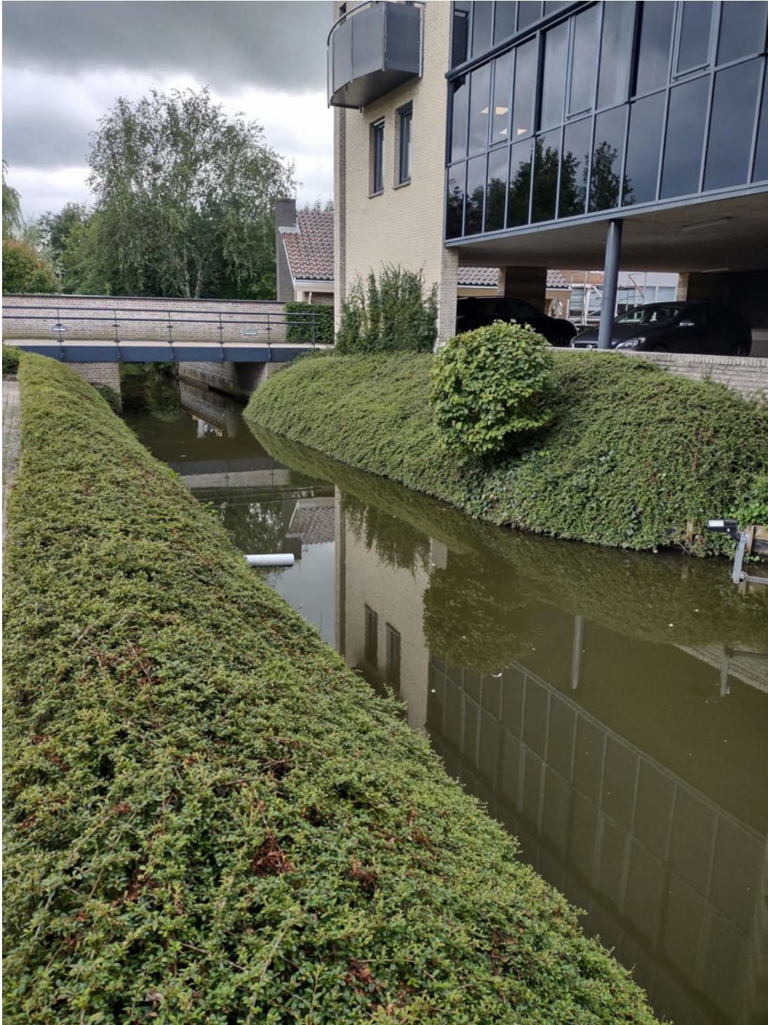
Afbeelding 14: Watergang aan noordzijde
