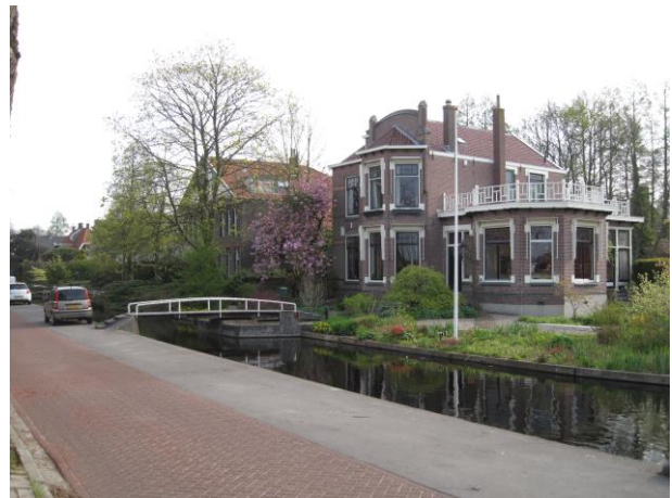
Zicht vanaf de Reijerskoop met sloot en Rozenlaan 2
