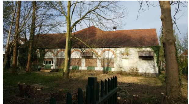
Achtergevel zaalgedeelte 12 april 2017
