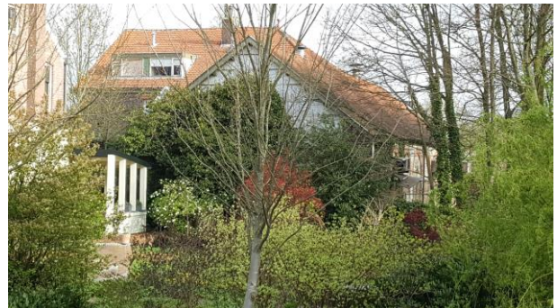
Rechter zijgevel zaalgedeelte en dakvlak voorgedeelte
