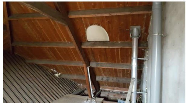
Fragment ruimte boven de zaal
