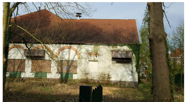
Fragment rechter deel achtergevel
