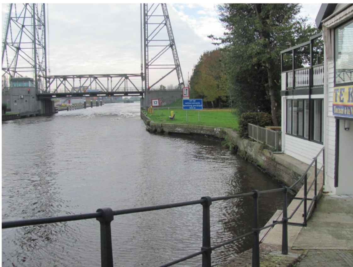
Foto 2431: Gouwesluisweg boringen 35, 36 en 37
