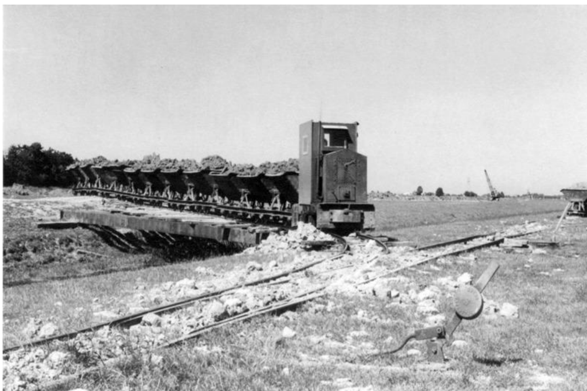
Afbeelding 8 Machinaal afvletten van klei rond het midden van de 20 e eeuw. De klei werd gewonnen en verwerkt door lokale pannenbakkerijen als de [REDACTED] in Alphen aan de Rijn. Pas eind jaren '80 kwam een einde aan deze grootschalige grondstofwinning aan beide zijden van de Oude Rijn. Bron: Provincie Zuid-Holland.
