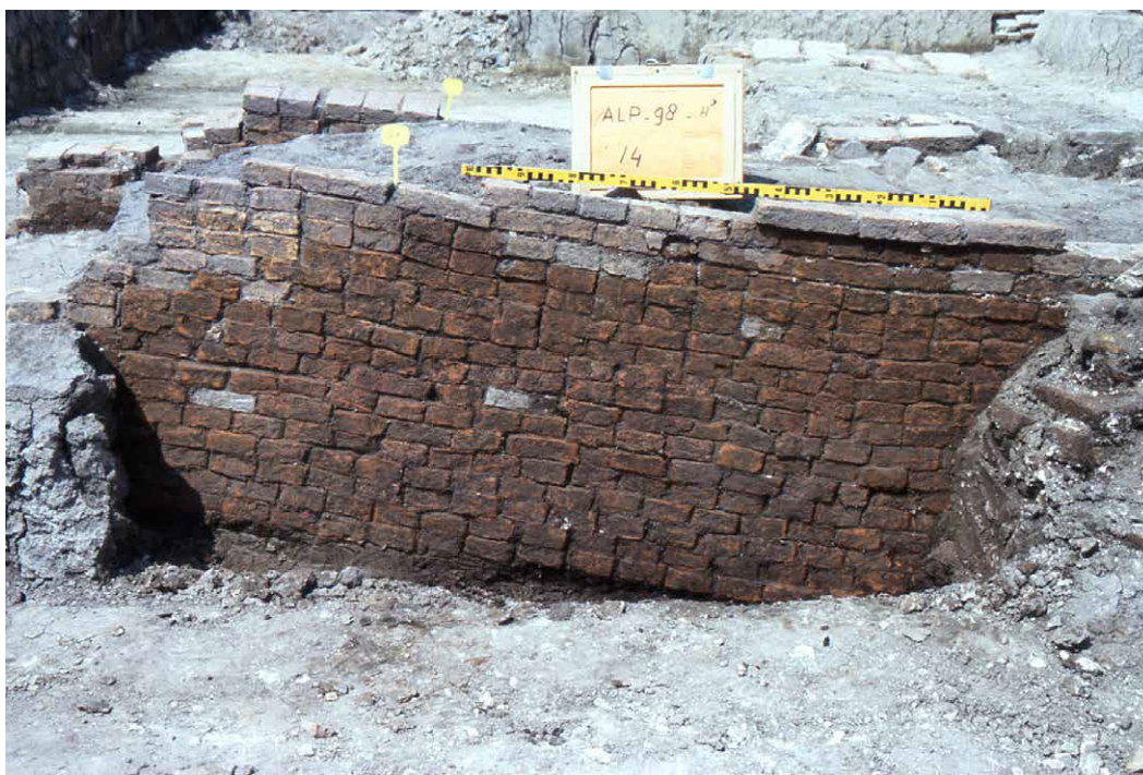
Afb. 5.3. Sterk verzakt muurwerk van spoor 14.
