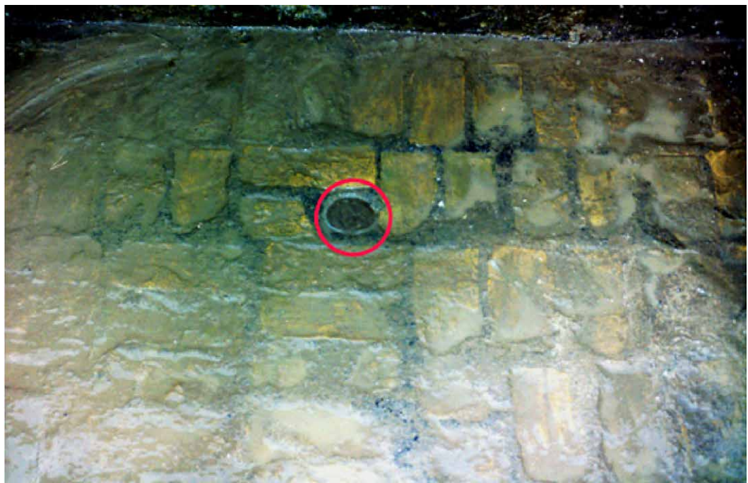
Afb. 4.6. Vloer van ijsselstenen met stop (rood omkaderd) van waterkelder S74.
