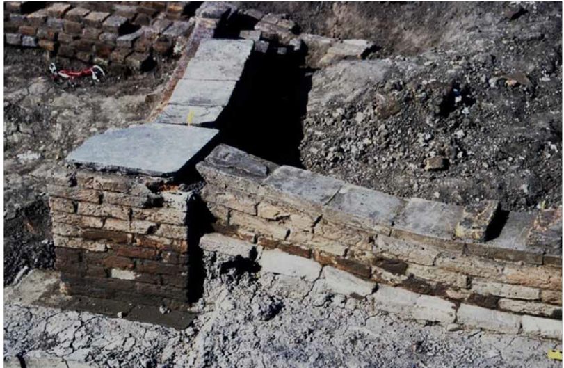
Afb. 6.14. Oostwaarts: ontstoppingsput in R9.
