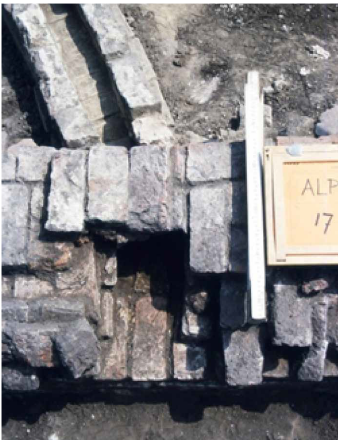
Afb. 6.3. Zuidwaarts: R1 aansluiting op en doorgang door de grachtmuur.
