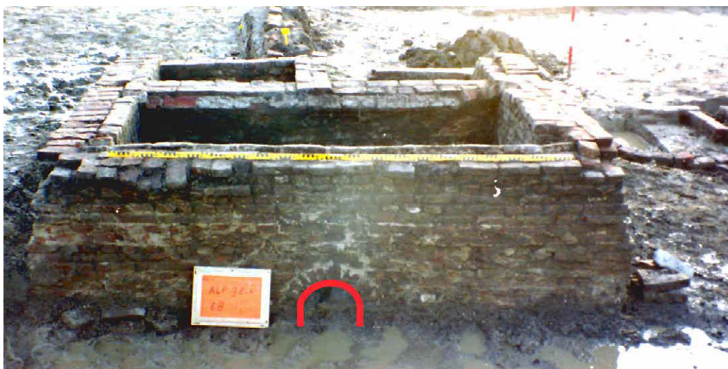
Afb. 4.8. Beerkelder met ruimgat rood omkaderd.
