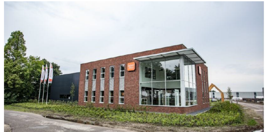
Voorbeeld kantoor uitgevoerd in donkerrode baksteen met verticale raamindeling
