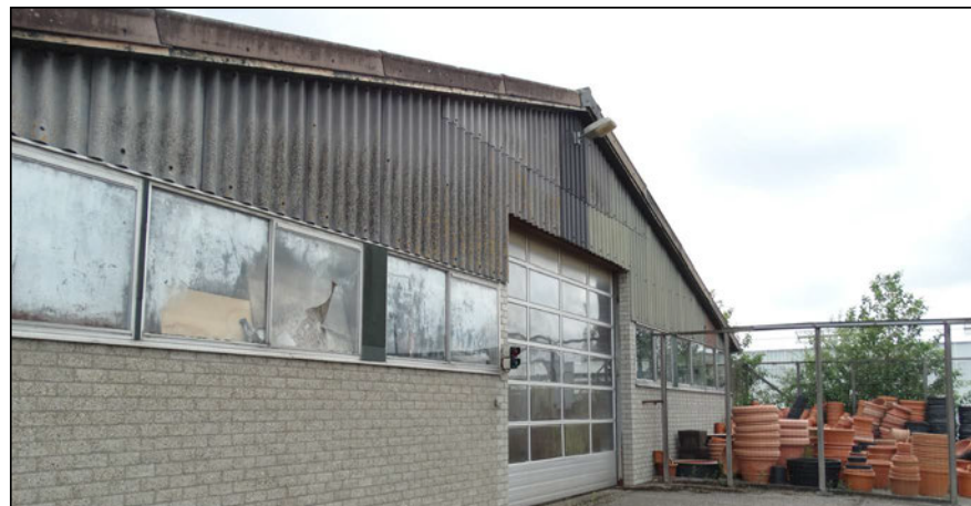
Figuur: de ruimte achter de golfplaten is ongeschikt voor vleermuizen aangezien ze zowel onder als boven open zijn. Verder zijn er geen kieren of spleten voor vleermuizen om in te kruipen.
