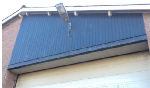
Figuur 9 & 10. Noordelijke kopgevel met gevelbetimmering (I) en kierende daklijst van de dakoverstek.
