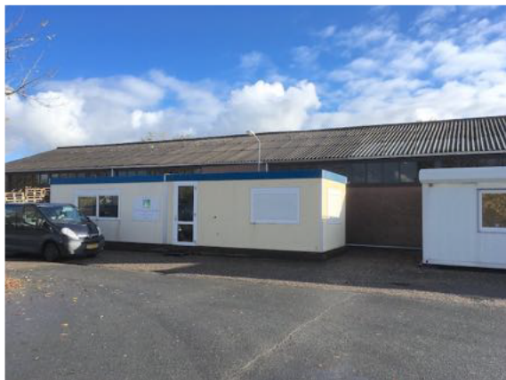
Figuur 3. Langsgevel van de loods met bijgeplaatste portacabins.
