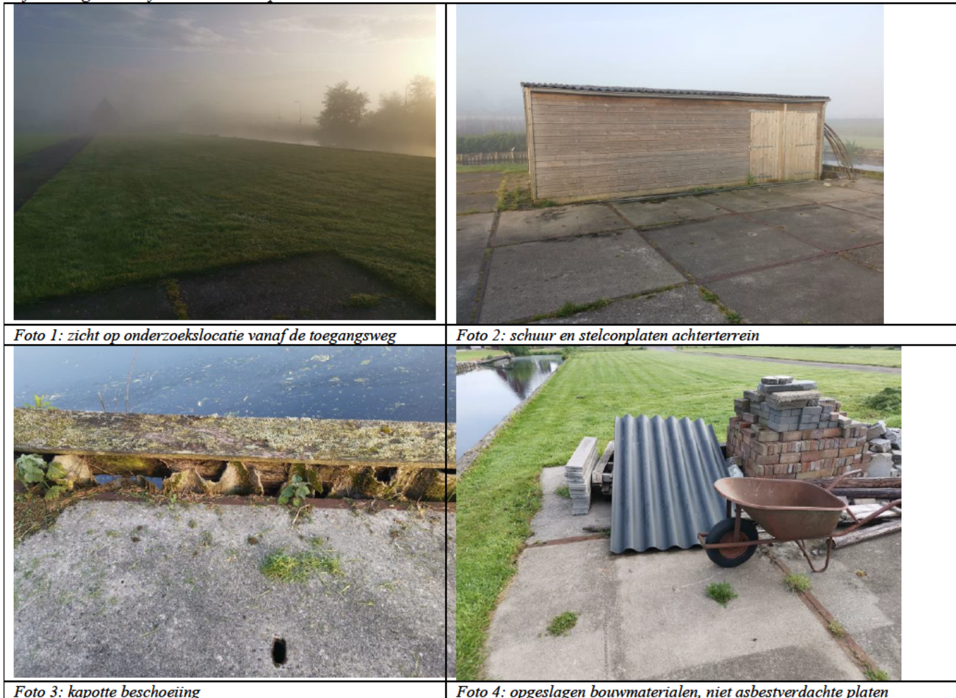
Afbeelding 2.2.1 - foto's locatie-inspectie d.d. 20 mei 2022
