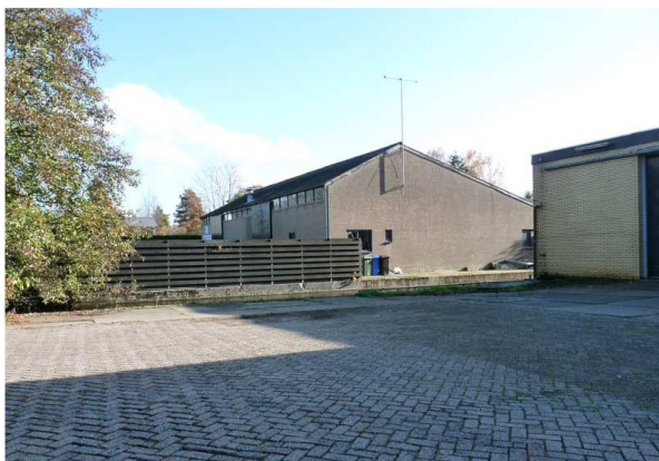
Figuur 20. De loods op het noordoostelijk deel van het plangebied. Foto genomen vanaf het westelijk deel, richting het oosten.
