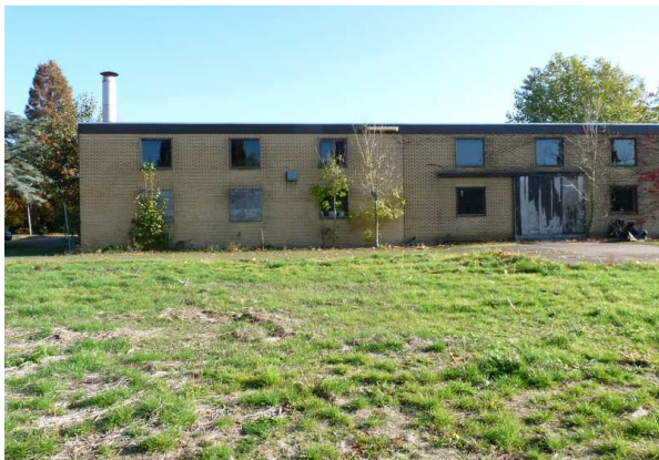
Figuur 10. De loods op het noordwestelijk deel van het plangebied. Foto genomen vanaf het westelijk deel, richting het noorden.
