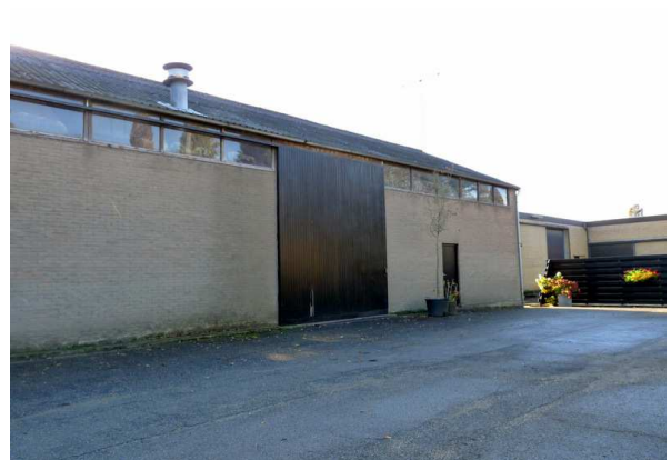
Figuur 21. De loods op het noordoostelijk deel van het plangebied. Foto genomen richting het westen.
