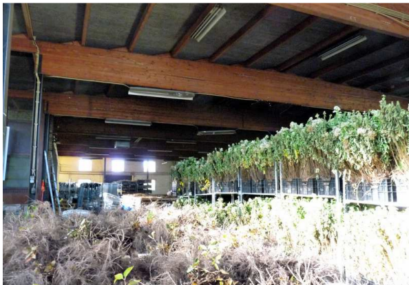
Figuur 12. Interieur van de loods op het noordwestelijk deel van het plangebied.
