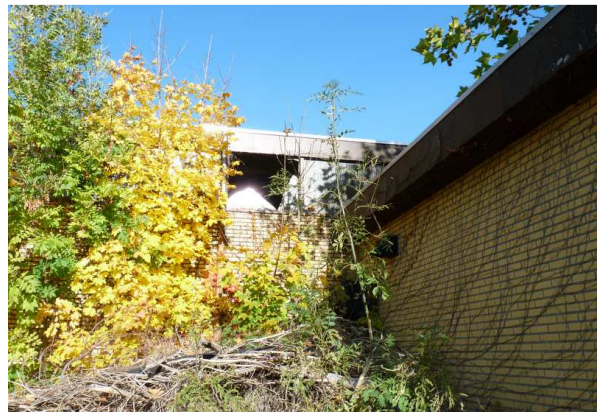
Figuur 11. Gebroken raam in de loods op het noordwestelijk deel van het plangebied. Foto genomen vanaf het westelijk deel, richting het noorden.
