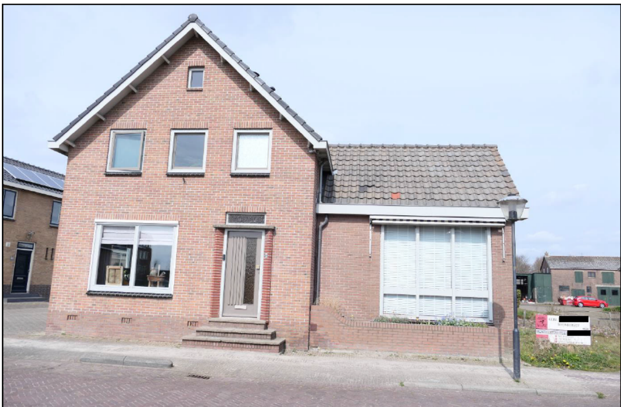
Figuur 1.2 Vooraanzicht van de woning aan de Dorpsstraat 99.
