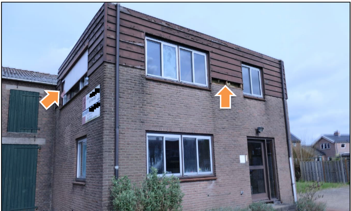
Figuur 4.6 Missende gevelpannen bieden toegang tot ruimte onder het dak voor vleermuizen.
