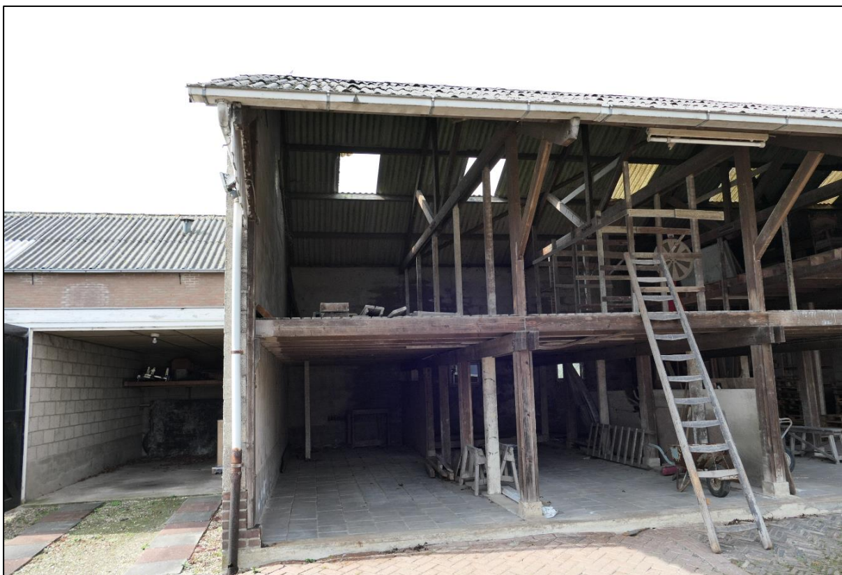
Figuur 1.6 Overzichtsfoto van enkele open schuren aan de Dorpsstraat 105.
