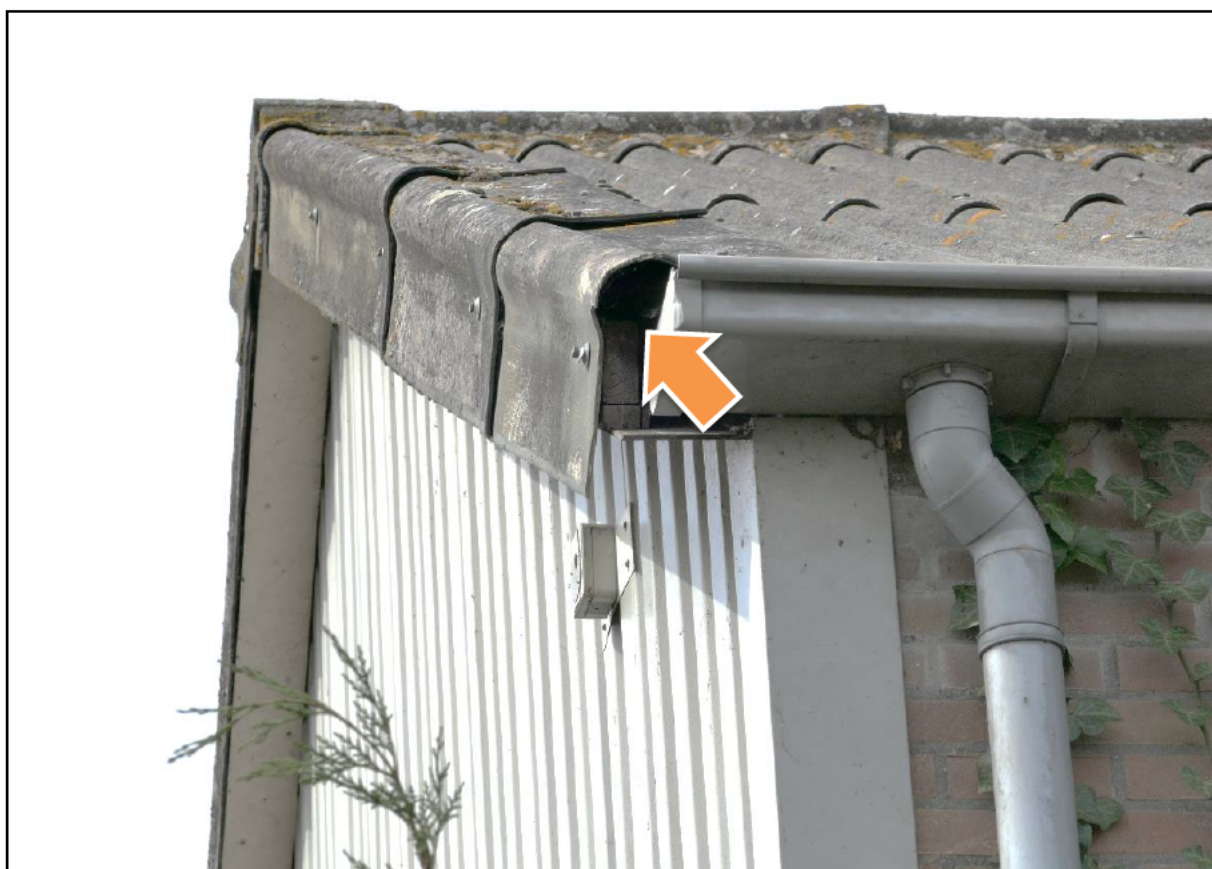
Figuur 4.3 Toegang onder het dak bij de schuur Dorpsstraat 97.
