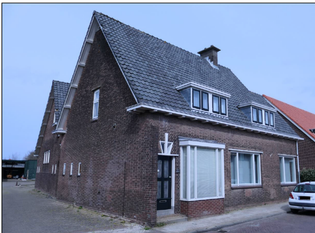
Figuur 1.4 Vooraanzicht van de woning aan de Dorpsstraat 111.
