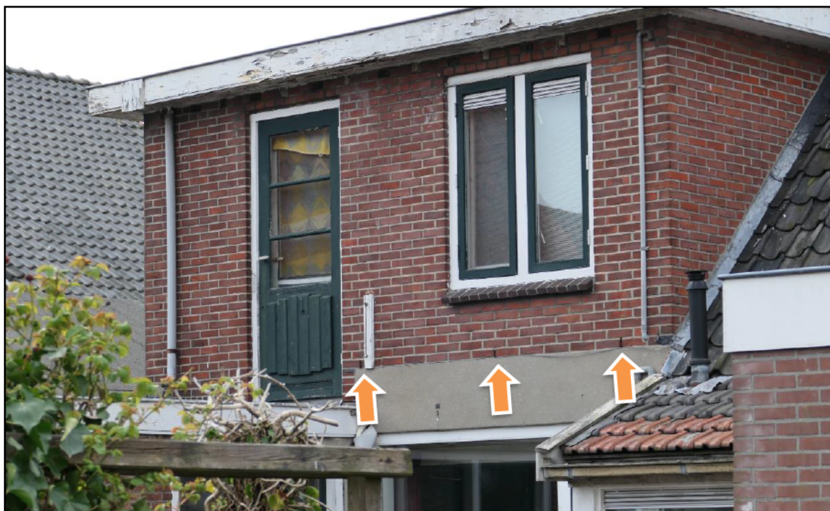
Figuur 4.5 Open stootvoegen aan de achterzijde van één van de woningen bieden toegang voor vleermuizen.
