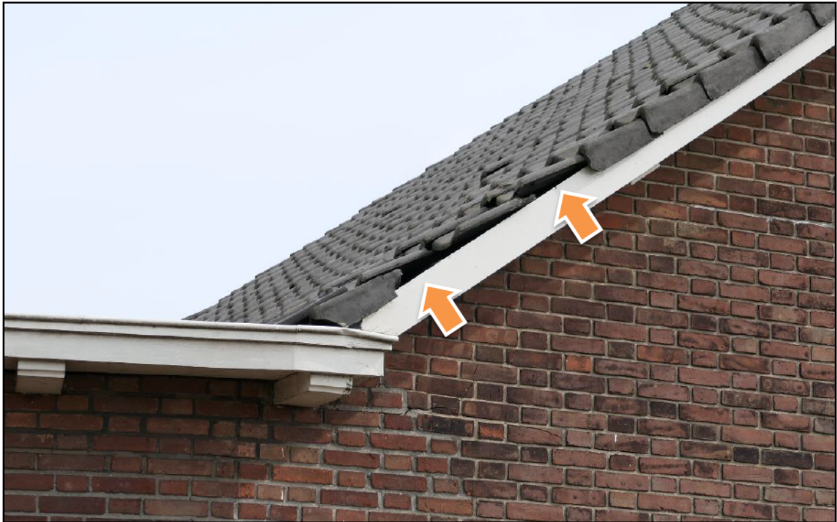
Figuur 4.6 Missende gevelpannen bieden toegang tot ruimte onder het dak voor vleermuizen.
