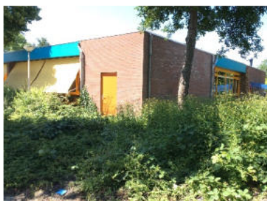
foto 1 - ter plaatse van peilbuis 01
