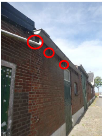
Figuur 3-2. De aangelegen schuur van het woonhuis van deelgebied 2 (ook deze bebouwing bezit dakpannen); openingen in de muur zijn rood omcirkeld.
