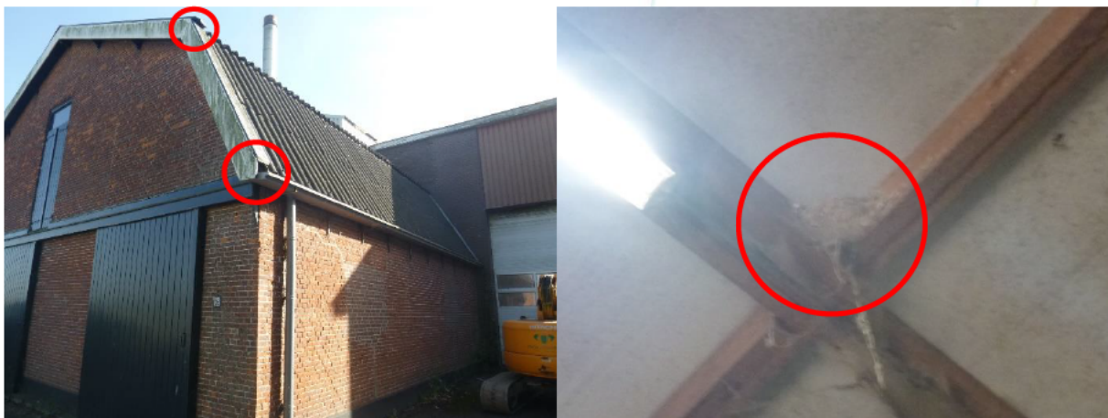
Figuur 3-1. Links de oude stal van deelgebied 1; openingen in de daklijst zijn rood omcirkeld en verder bezit het gebouw dakpannen. Rechts een zwaluwnest in een van de oude schuren.
