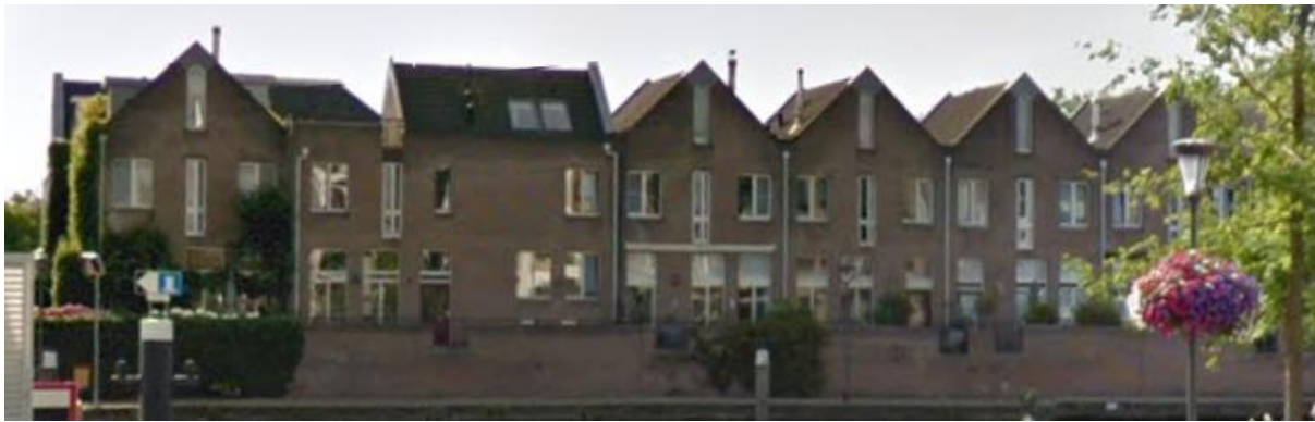
Figuur 17: Gevel aanzicht Curaçaostraat, Google Maps, Street view.
