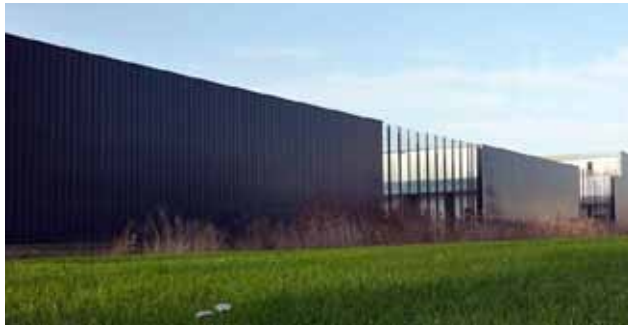
Opslag/expeditie achter #schijngevel, #materialisering, #kleurstelling.
