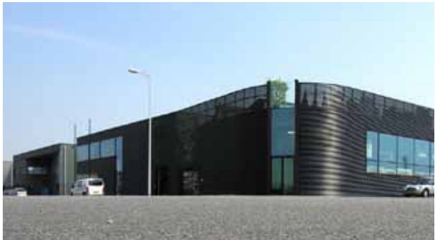
#(afge)ronde hoeken, #materialisering, #kleurstelling, #insnijdingen, #schijngevel
