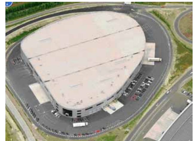
#(afge)ronde gebouwen uit één stuk in infrastructureel landschap
