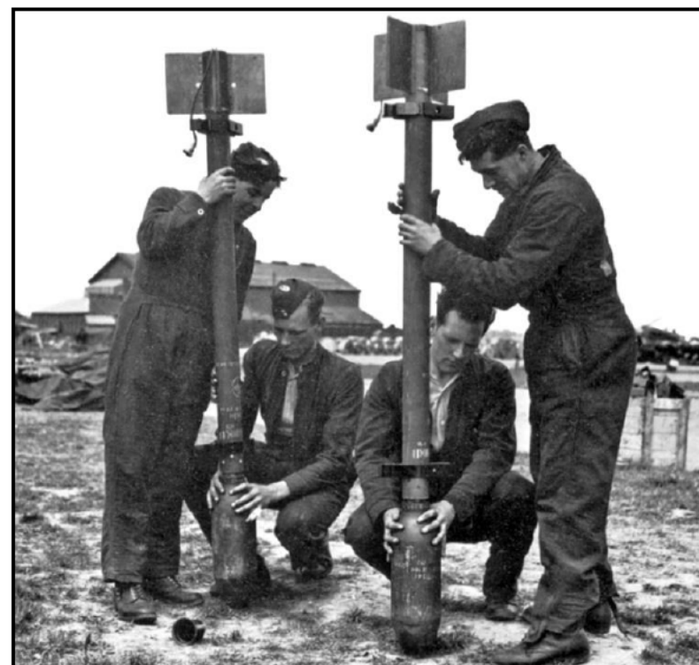
Figuur 21. Voorbeeld van het samenstellen van de 3 inch raketmotor met een gevechtslading SAP-HE van 60 lb.
