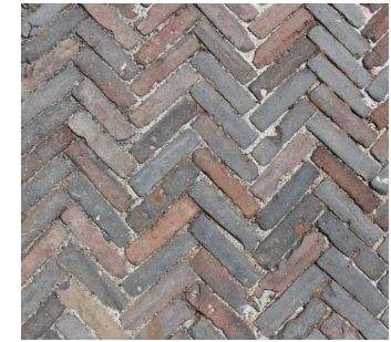
Gebakken klinkerbestrating (Rijnklinker) t.p.v. parkeren en terras
