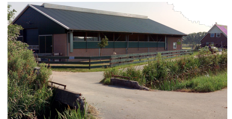
Geasfalteerde verharding (oprit naar nr. 83a)
