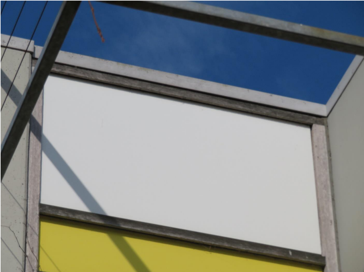
Naadloze aansluiting trespas sierplaten op beton.
