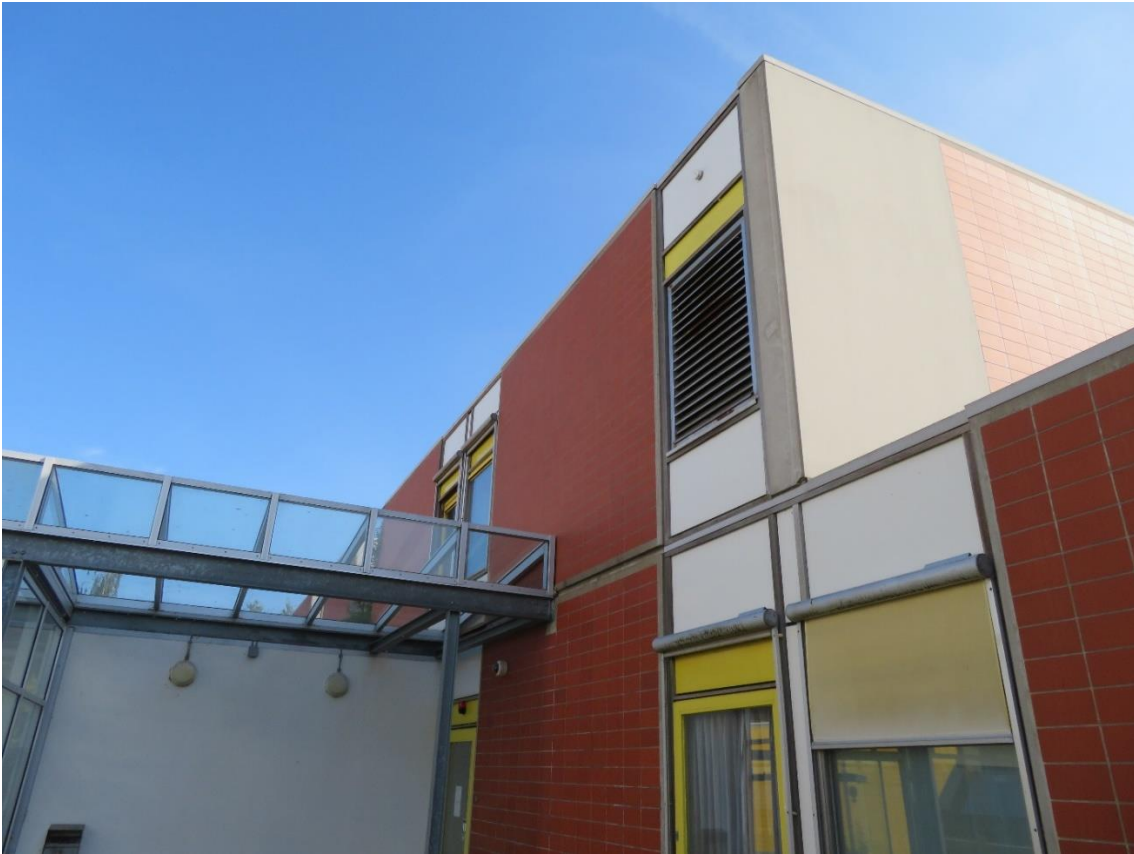
Detailfoto van gevels met tegels en trespa sierplaten.
