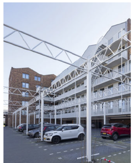
stalen hulpconstructie 'klimgroen' ✗ Het Gemaalhuis, Hoofddorp, studio VVHK
