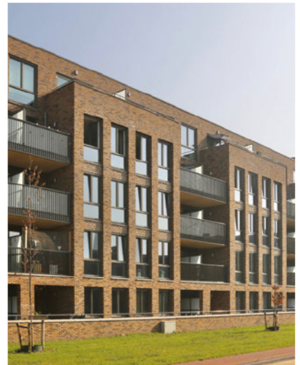
repeterende gevelopbouw ✗ Enka, Ede, MIX
