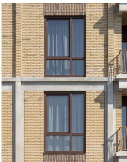
gelaagde gevelopbouw ✓ Westergouwe, Gouda, Eentien
