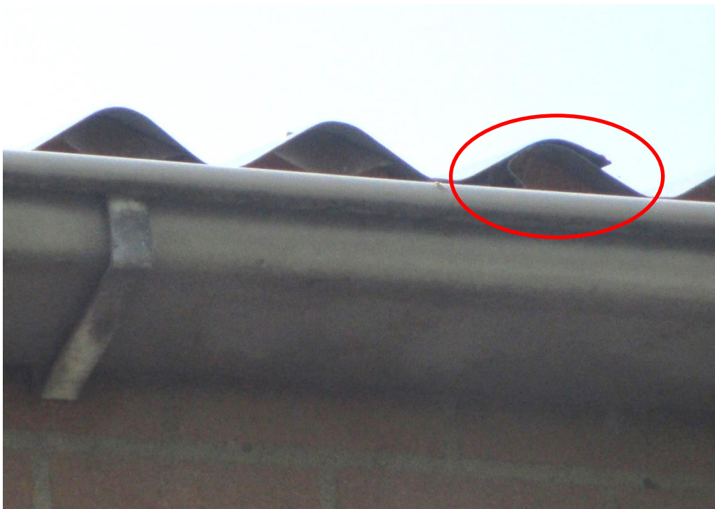
Figuur 6 Onder de golfplaat daken van stal A en B is isolatiemateriaal aangebracht, waardoor deze ontoegankelijk zijn gemaakt.
