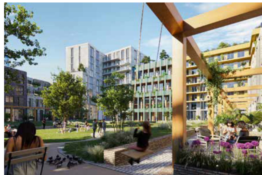
In de binnentuinen kunnen bewoners beschermd verblijven en recreëren.
