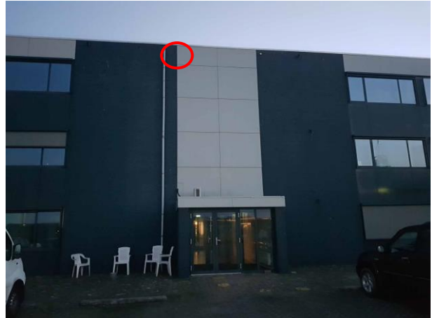
Figuur 7: Locatie paarverblijf pand B, achterzijde
