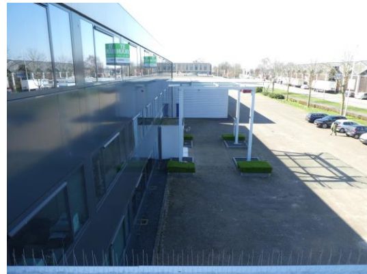
Figuur 19 Trespa platen voorzijde gebouw B
