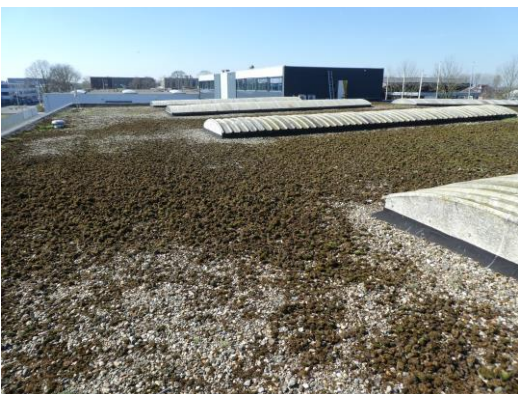
Figuur 18 Dak gebouw A
