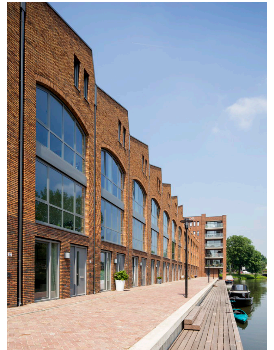
Het industriële karakter van de Rijnhaven is leidend voor de architectuur.
