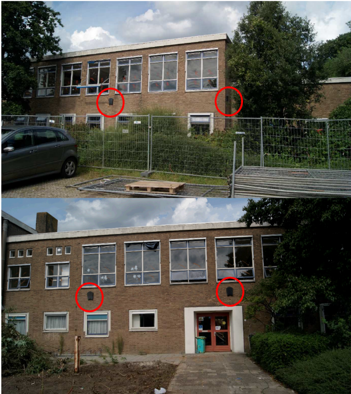
Afbeelding 4 en 5: vier vleermuiskasten op de gevel van het te slopen pand.
