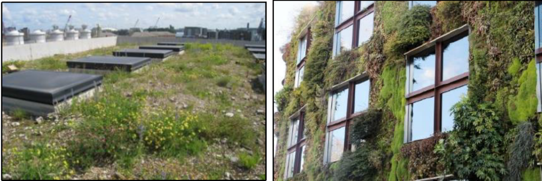
Figuur 8: Bruin dak (links bron: checklist groen bouwen) en groene gevel (rechts bron: groenkennisnet.nl).
