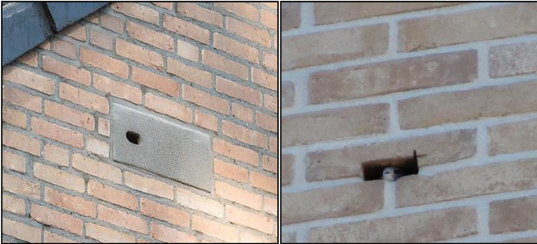
Figuur 2: Inmetselstenen zichtbaar (links) en onzichtbaar (rechts) in de gevel verwerkt (bron: Vivarapro).
