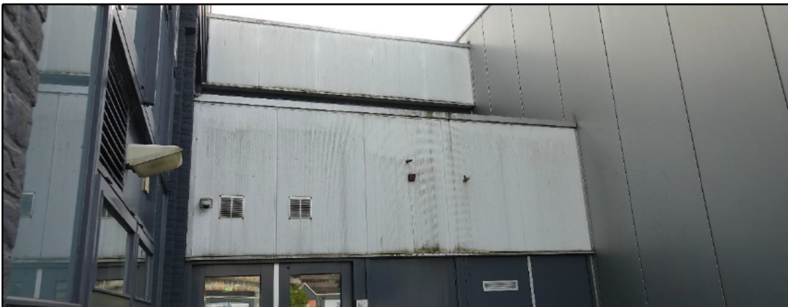
Figuur 12: Tussen de bedrijfspanden en naastgelegen woontoren (buiten het plangebied) is een verbindingsstuk aanwezig wat bekleed is met Trespa, waardoor vleermuizen hier niet verwacht worden.
