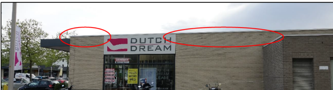
Figuur 13: Open stootvoegen zijn voornamelijk gesitueerd op de hoeken en kopsen kanten van de gemetselde opstallen.
