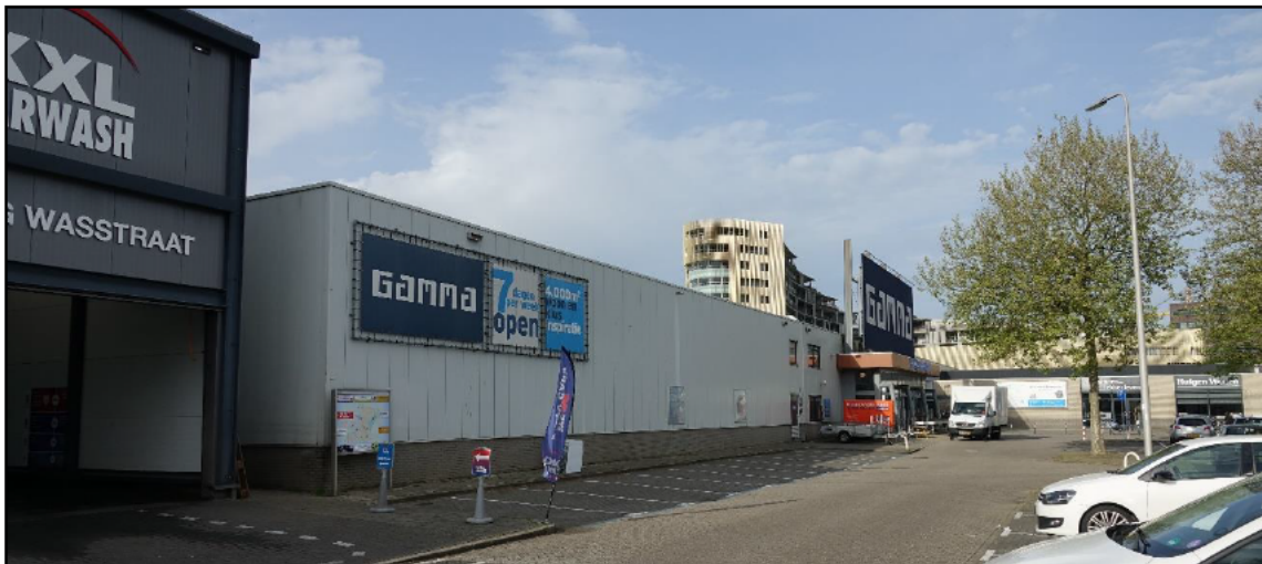
Figuur 5: Bij andere gebouwen is de gevel bekleed met metalen platen.
