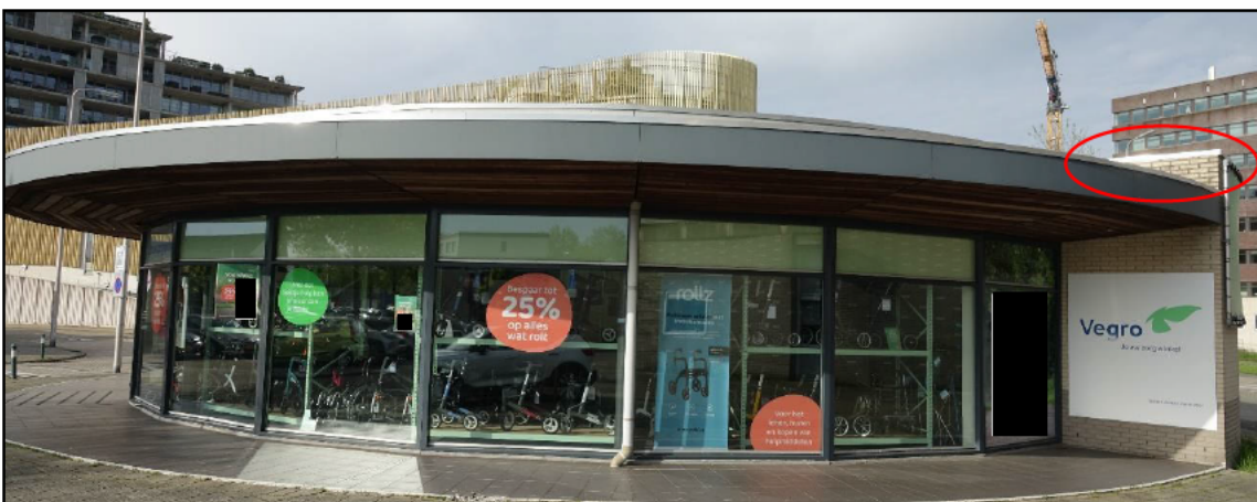
Figuur 16: Van de open stootvoegen op de "hoeken" wordt de vrije aanliegroute geblokkeerd door de onderliggende overkapping, waardoor deze stootvoeg niet geschikt is als toegang tot een verblijfplaats.
