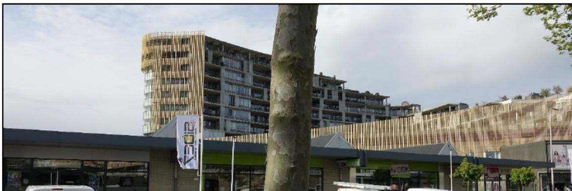
Figuur 10: Direct ten noorden van het plangebied zijn enkele hoge woontorens aanwezig welke in principe een geschikte broedplaats voor de slechtvalk kunnen vormen.
