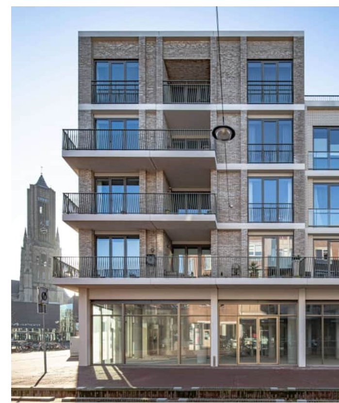
Plint en gevelopeningen.
