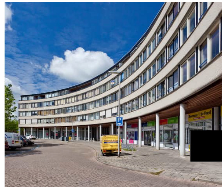
2. Euromarkt: gekromd appartementencomplex met gevarieerde commerciële plint.
