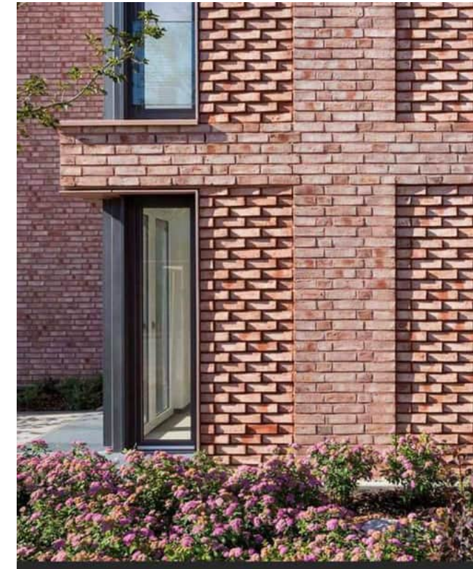
Verbijzondering in het metselwerk.
