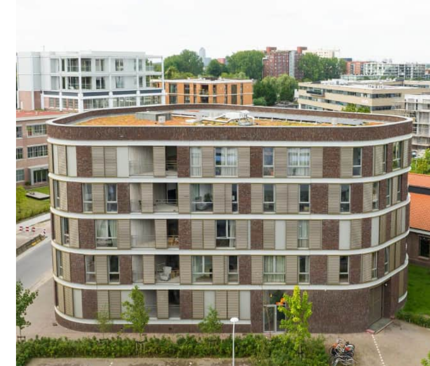
Installaties op het dak zijn niet zichtbaar vanaf de grond, de beëindiging kan hierbij helpen.
