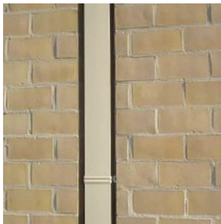
Hemelwaterafvoer in het vlak van het metselwerk uitgevoerd.
