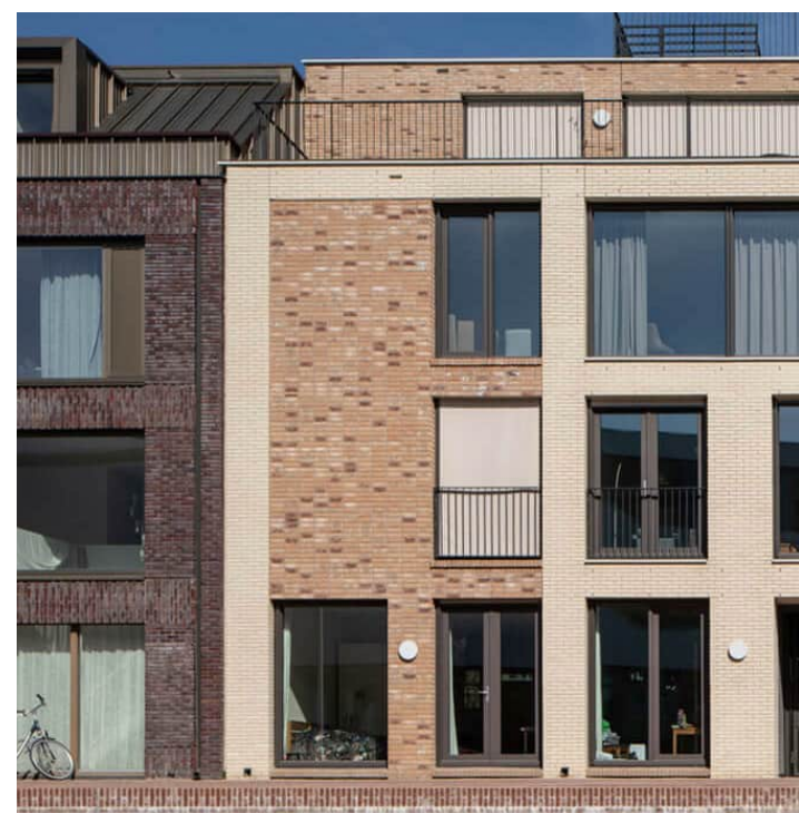
Hemelwaterafvoer inpandig opgelost.
