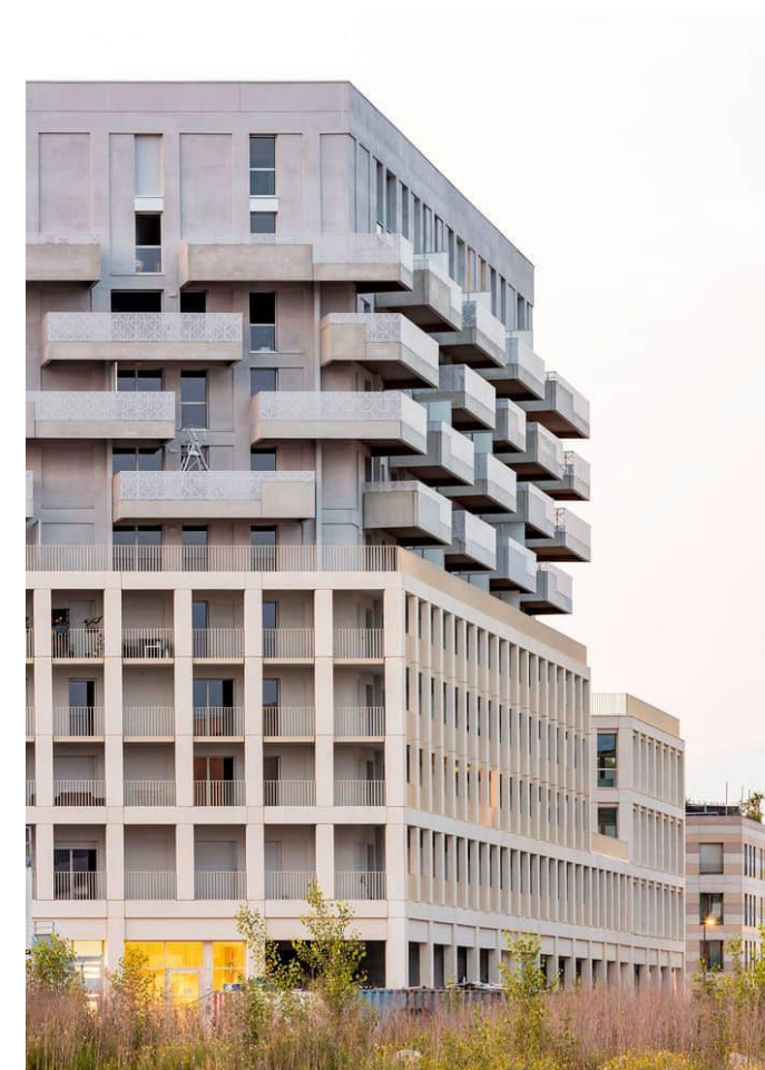
De verschillende lagen zijn afleesbaar in de gevel.
