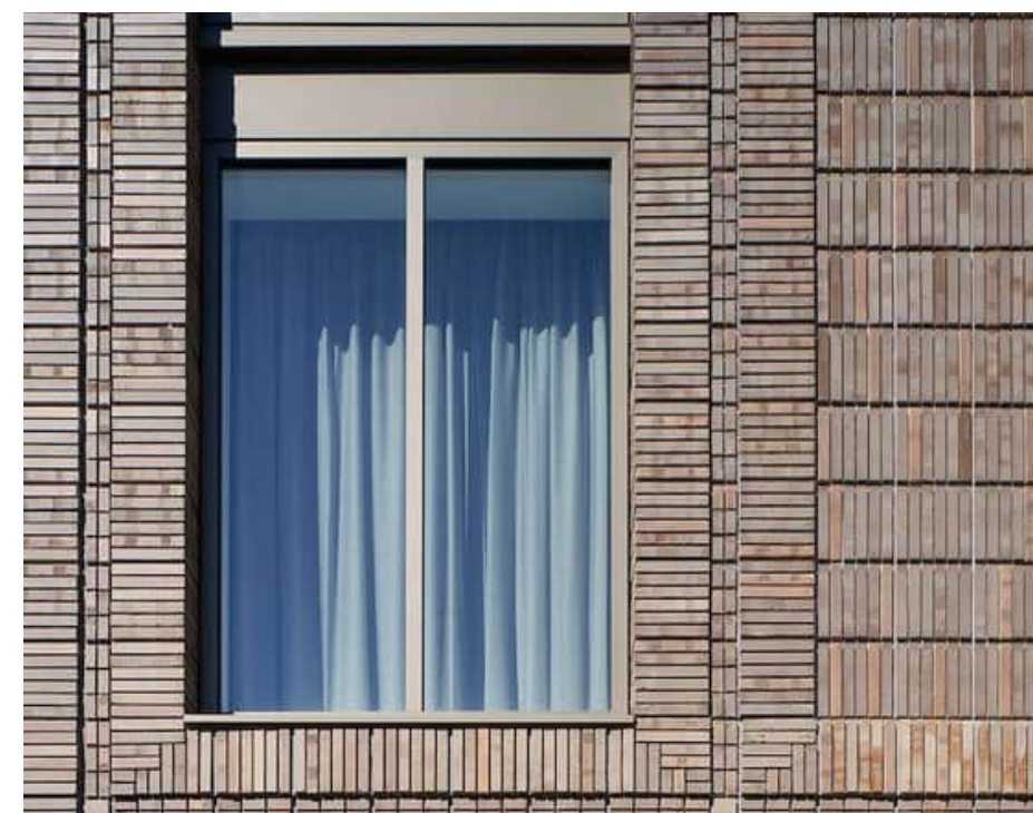
Samenspel tussen materialisatie en kozijnen.
