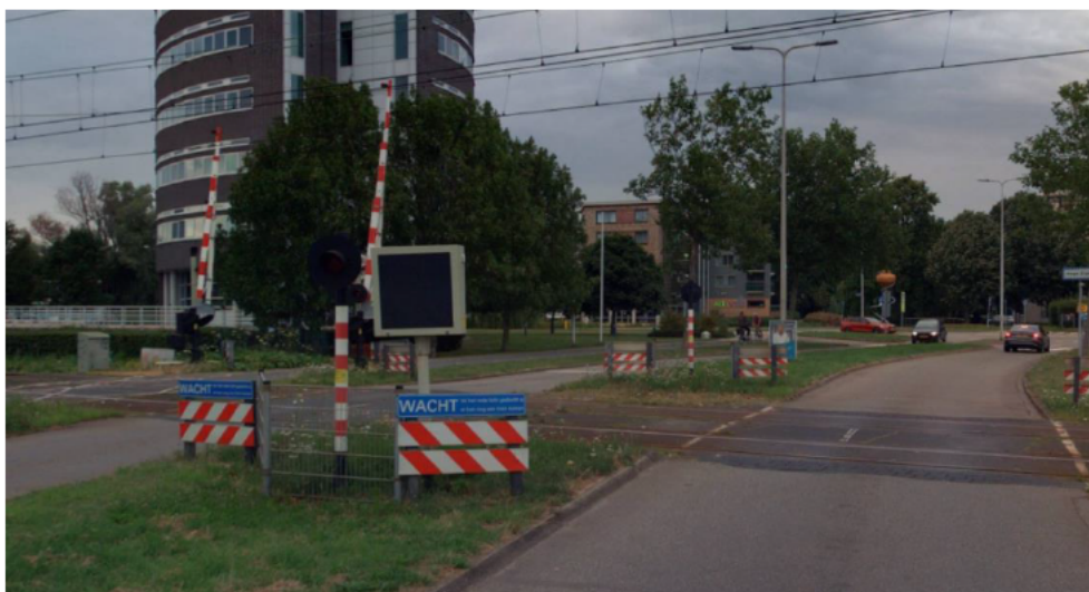
Figuur 4.3: Dynamisch signaleringsbord om wachtrijen op de spoorwegovergang te voorkomen
